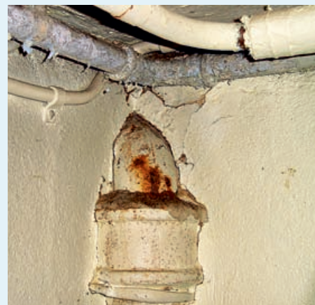
Figur 2. Rostrosor på utsidan av en vertikal köksstam i källaren i en fastighet i Sollentuna. Stora områden på röret har blivit genomgrafiterade. FOTO: VINKA/ALMQVIST
