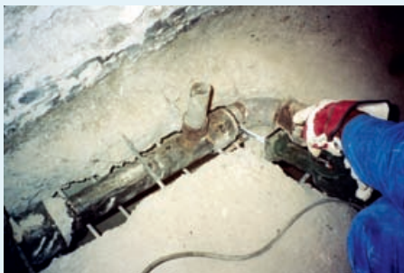
Figur 5. När rören frilagts kapades de ner i lämpliga längder.
